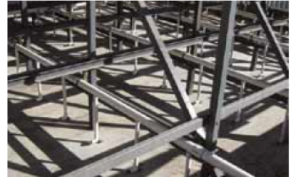
냉각탑 내에 세워져 설치되어 있는 하이드로부스터 배치 모습.
